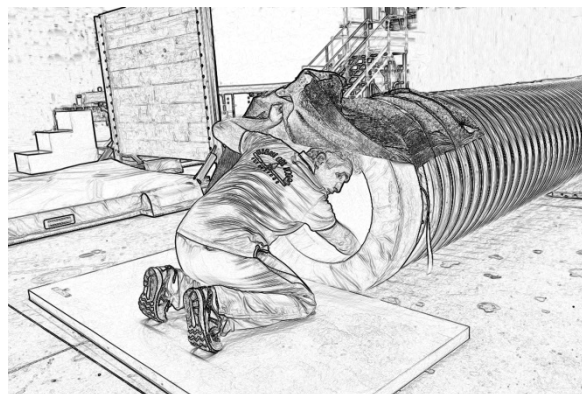
figura 7: Ingresso nel tunnel
